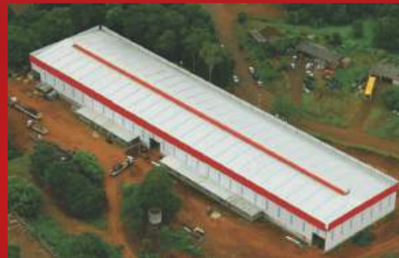
Novo parque fabril em construção.
