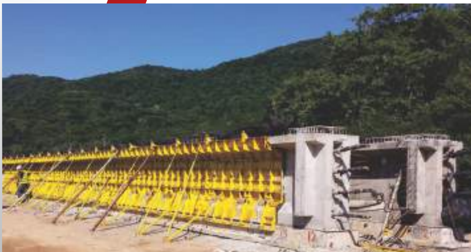
Fôrma Viga Ponte
