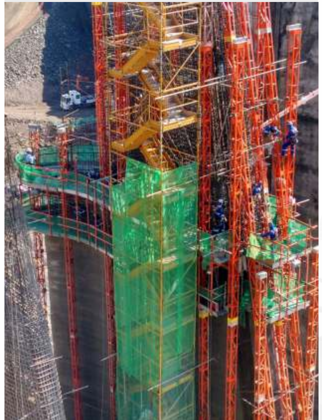
Aplicação do sistema de formas para pilares da Tomada D'água.
