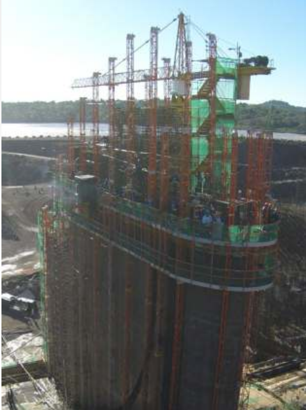
Aplicação do sistema de formas para pilares de Vertedouro.
